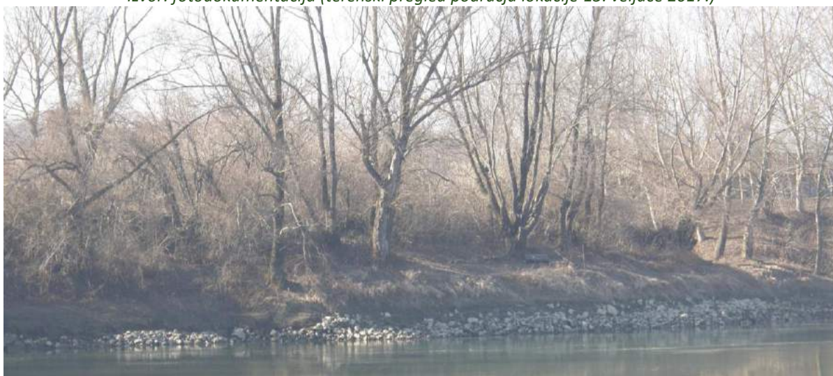
Fotografija 3-4: Područje lokacije zahvata – kameni nabačaj na desnoj obali Izvor: fotodokumentacija (terenski pregled područja lokacije 15. veljače 2017.)
