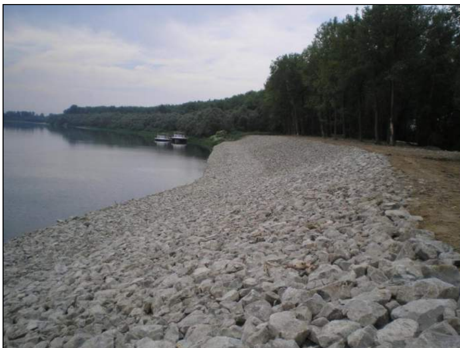
Fotografija 2-6: Izgled obaloutvrde sanirane krupnim kamenom
