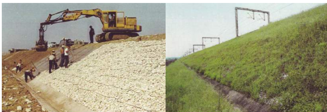
Fotografija 2-7: Ugradnja i izgled gabionskih madraca nakon sanacije
